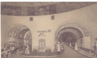
Der markante quadratische Kuppelbau an den St. Pauli-Landungsbrücken beherbergt die Maschinerie für die vier großen Fahrkörbe, die Menschen und Fahrzeuge seit 1911 in fast 24 Meter Tiefe transportieren, wo zwei gekachelte, 6-m-Durchmesser Tunnelröhren zum südlichen Elbufer nach Steinwerder führen.
